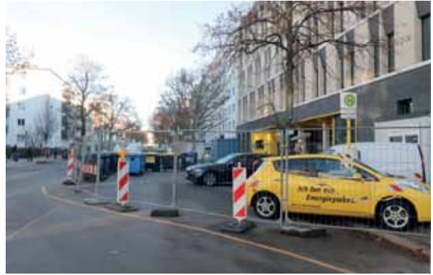
BVG-Baustelle in der Usedomer Straße, für die die Straße teilweise gesperrt wurde. Unten: Blick auf den Neubau. Fotos: Andrei Schnell
